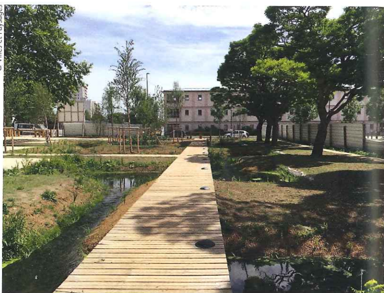
Dans le parc Molière, poumon vert de la rénovation urbaine, l'eau est mise en scène à travers plusieurs ambiances. Des platelages en pin traité classe 4 offrent des cheminement en surplomb, au plus près de l'eau.
